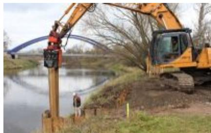
Mitarbeiter des Bad Dübener Unternehmens Bau- und Haustechnik rammen unweit der Muldebrücke Spundbohlen in das Ufer. Hier entsteht bis Ende Januar der Bootsanleger. Foto: (Wsp) Philipp
